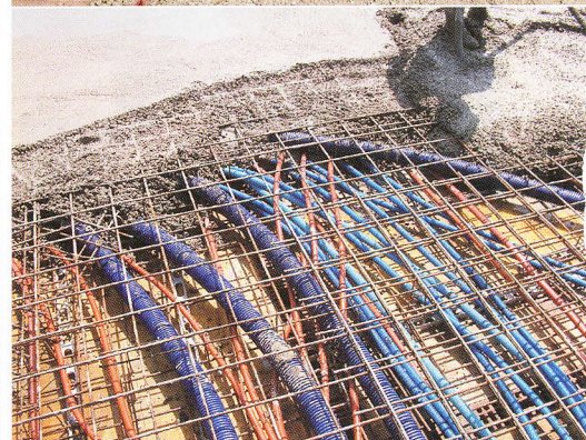
Pour construire la maison sur des fondations en béton, le sol a été creusé. La terre et les pierres sont restées sur le terrain pour éviter des transports. Une ossature bois a été montée en quelques jours. Tout le câblage nécessaire a été noyé dans le béton et dans une gaine technique. Le plan montre les zones déterminées par le Feng Shui (ci-contre).
